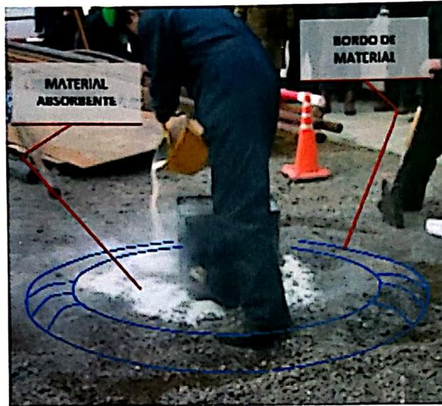
Fotografía N°2-Contención de un derrame
